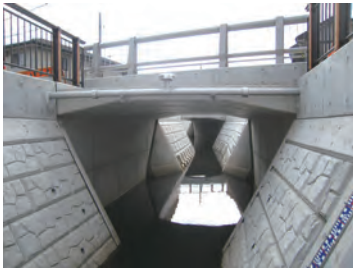
▲群馬県館林土木事務所 4400×2900
