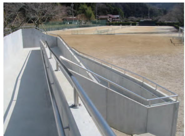
▲天端・側壁に手すり取付例
